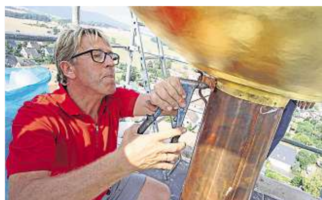
Michael Kaufmann montierte unterhalb der Turmkugel den Blitzschutz – eine filigrane Angelegenheit.
