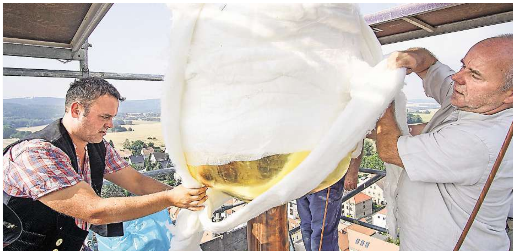
Ein spannender Moment: Sebastian Winter (l.) und Konrad Riedel packen vorsichtig den Turmknopf, von den Hochkirchern nur Fass genannt, aus. Erst danach kommen auch die Wetterfahne und der Stern auf die Kirchturmspitze. Und das alles in luftiger Höhe von über 50 Metern.
